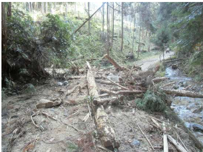
台風の影響による流木でふさがれた足谷林道
