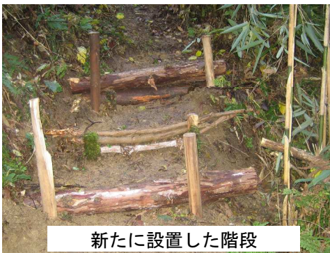
出来た階段を踏み固めて
