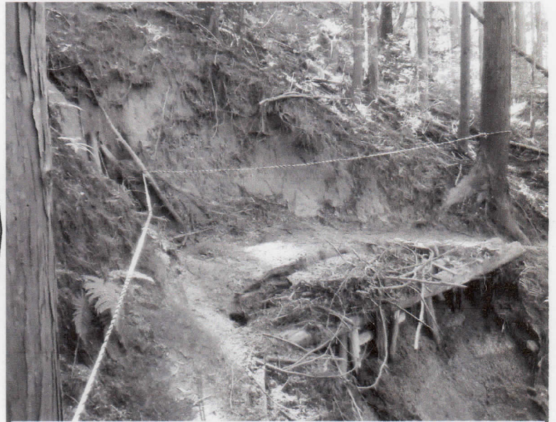
崩落している登山道の山手側にロープを設置
