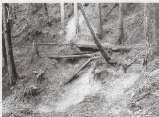
道が崩れ 杭も腐ってグラグラ
